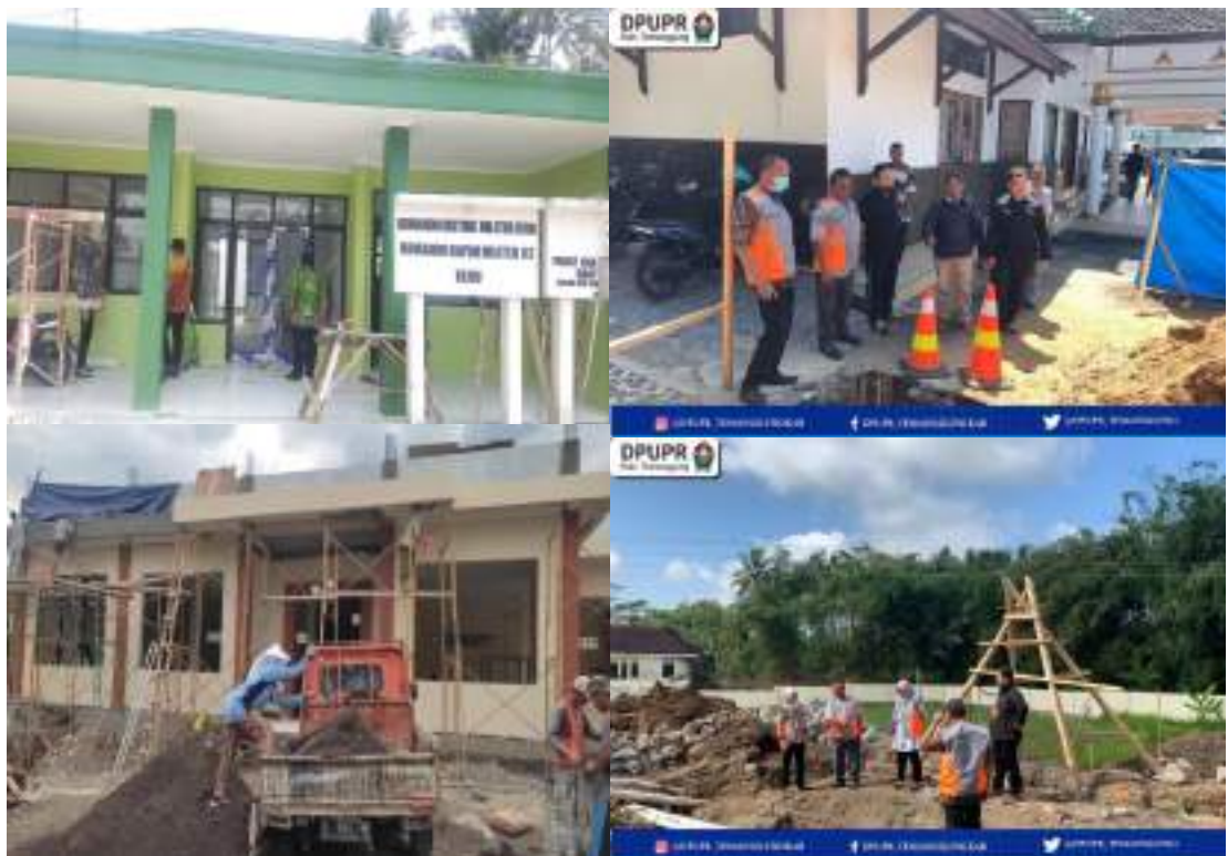
Gambar 3.5 Pembangunan Gedung Koramil Kedu Monitoring Pembangunan Gedung Kejaksaan dan Makopolres Temanggung
