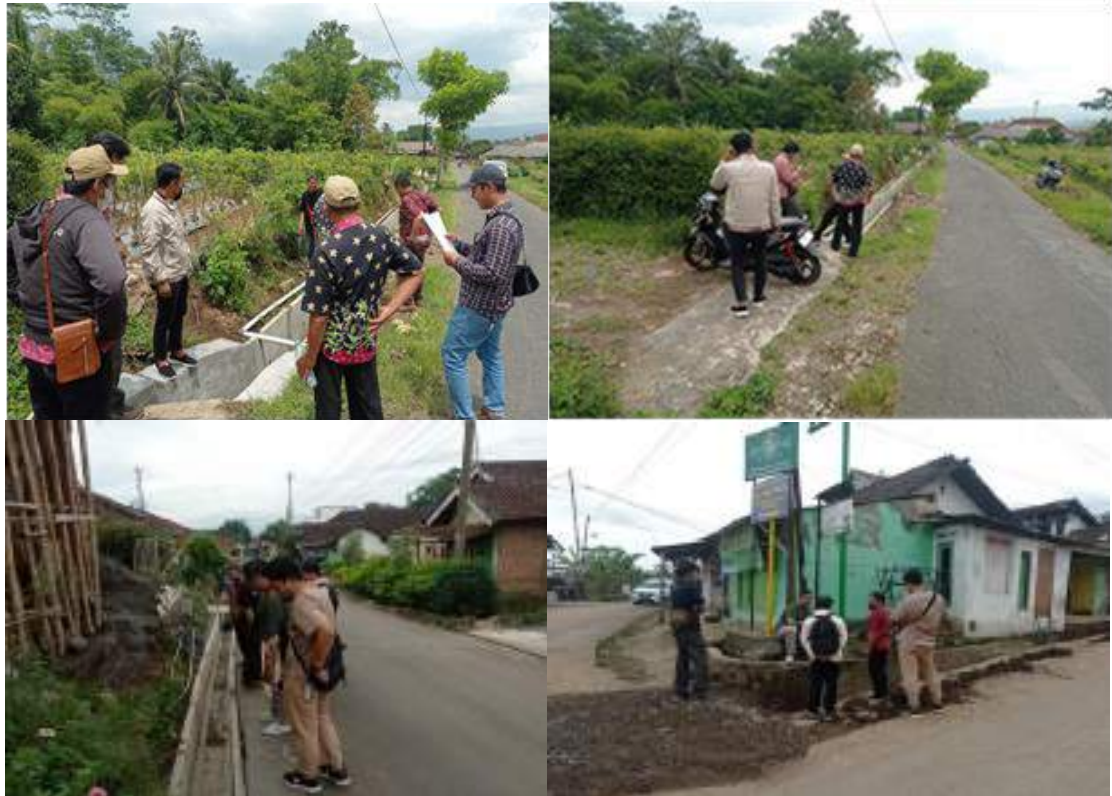
Gambar 3.3 Pembangunan Drainase Jalan Dusun Getis Gilingsari s.d. Desa Candisari (M) Pekerjaan Pembangunan Drainase Jalan Raya Menggoro - Tawang Sari (M)
