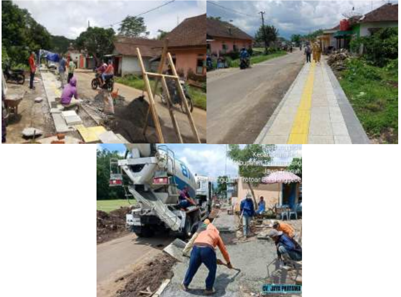
Gambar 3.6 Pekerjaan Pembangunan Trotoar Bandunggede
