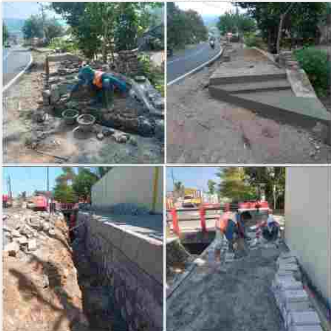
Gambar 3.12 Pemeliharaan Trottoir Ruas Jalan Ngadirajo – Tegong Pemeliharaan Trottoir Ruas Jalan Murtung – Jumo
