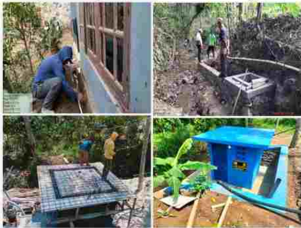
Gambar 3.5 Peningkatan SPAM Jaringan Perpipaan Desa Purwosari Kecamatan Kranggan (DAK)
