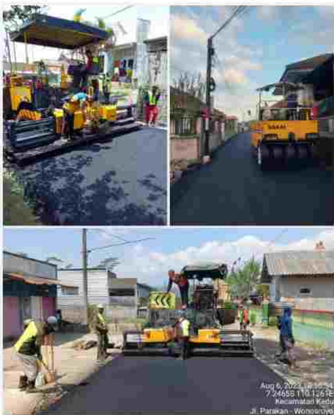
Gambar 3.14 Penanganan Long Segment Jalan Parakan - Wonosroyo (DAK)
