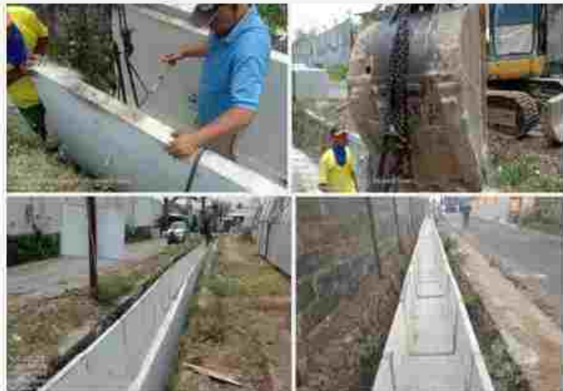
Gambar 3.7 Pembangunan Drainase Ruas Jalan Sudikampir-Delok (M)
