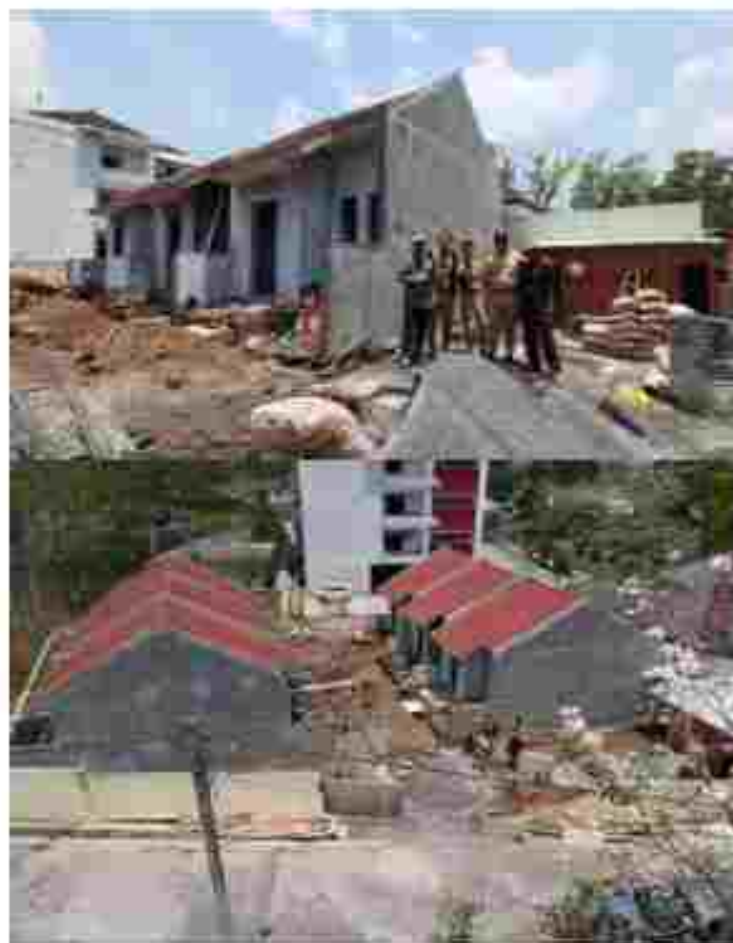
Gambar 3.10 Pembangunan Rumah Dinas Jaksa
